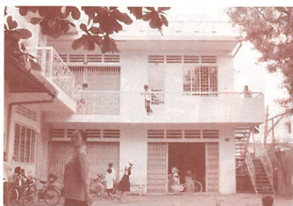
2階建ての建物内に、教室や運動できる部屋がある。
