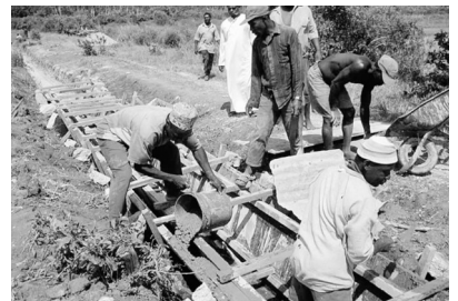
水路建設の様子
