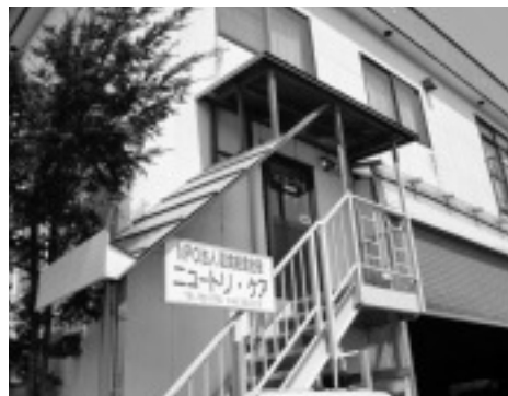
自宅を改造して作った外階段付き厨房
